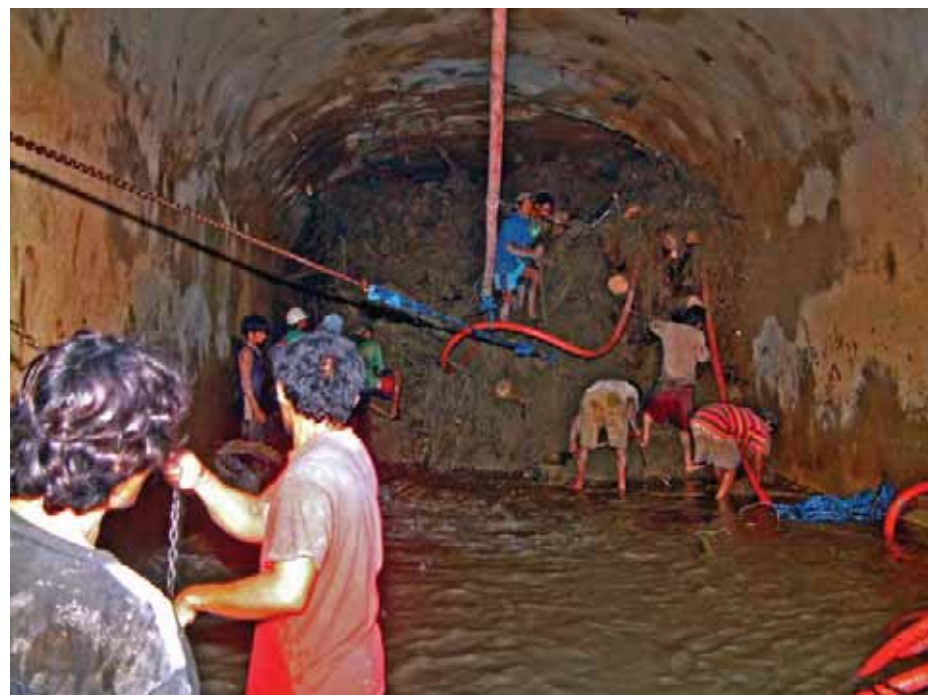
Ruční čištění tunelu (foto EDCOP)
