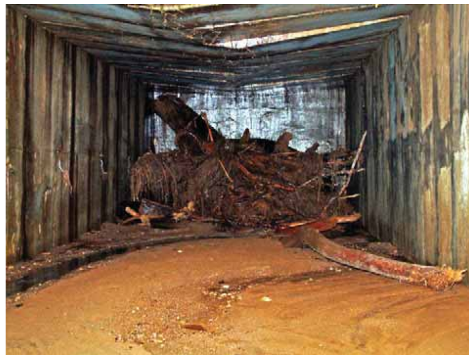
Nápuštní kanál tunel
