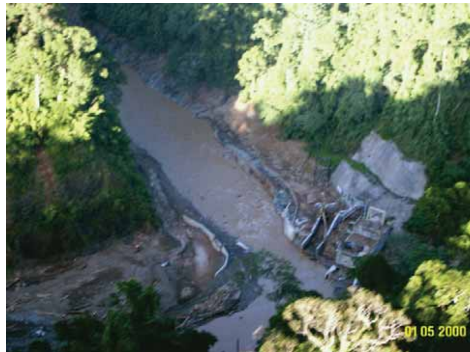
Výtokový objekt a MVE, po tajfunu (foto EDCOP)
