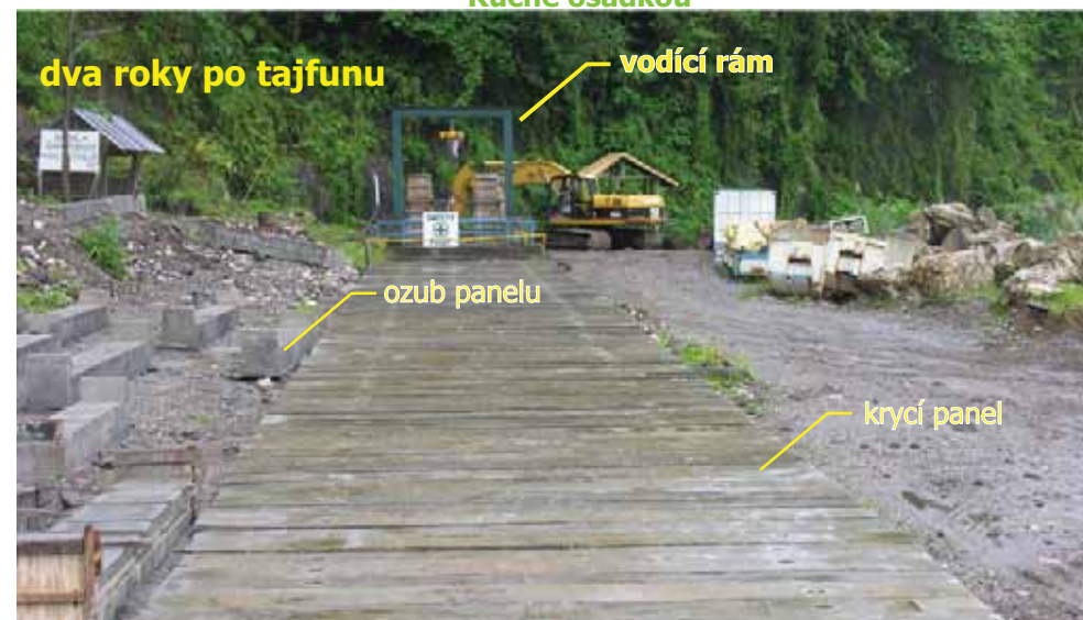
Obr. 26 Vstup do tunelu
