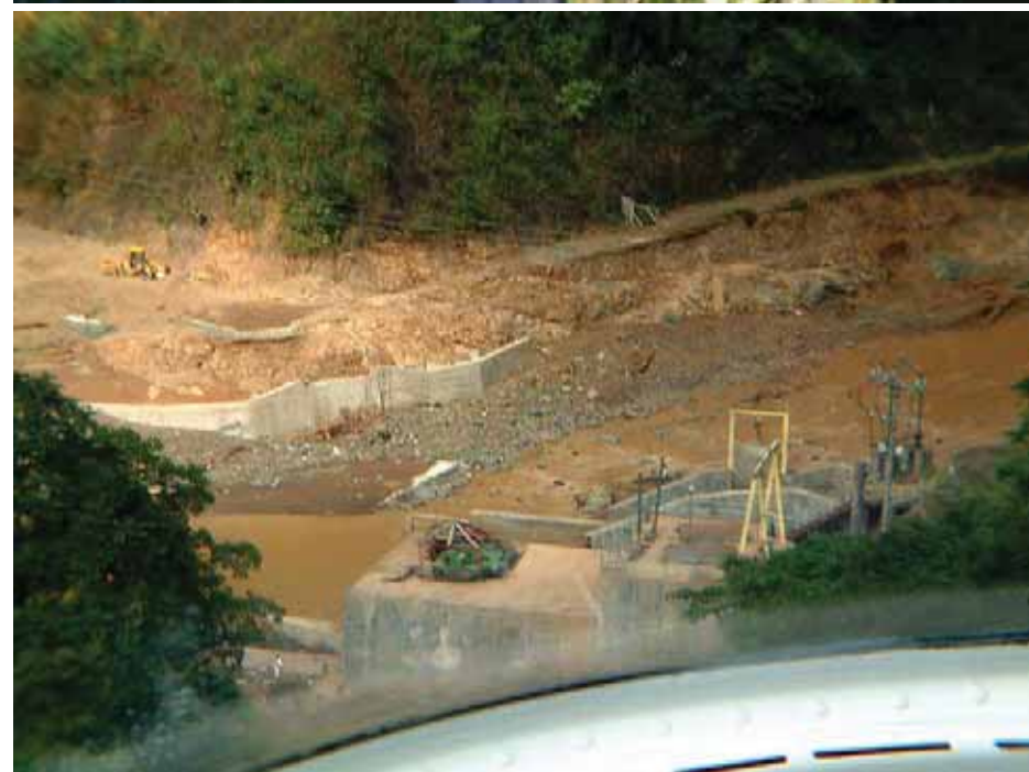
"Pravé zavázání mostu" (foto EDCOP)
