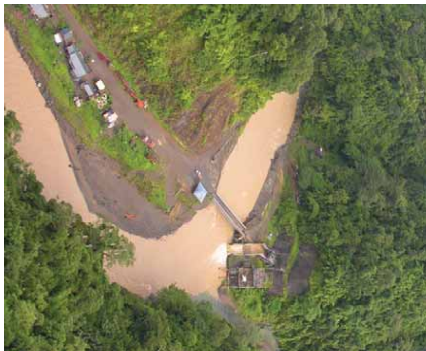
Letecký pohled na most přes řeku Macua (šířka řeky pod mostem 30 m, šířka nad mostem 38 m)
