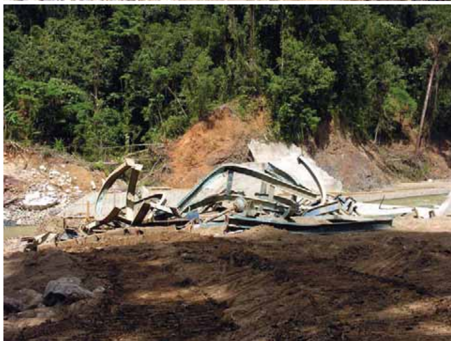
Obr. 24 Vstupní objekt po tajfunu
