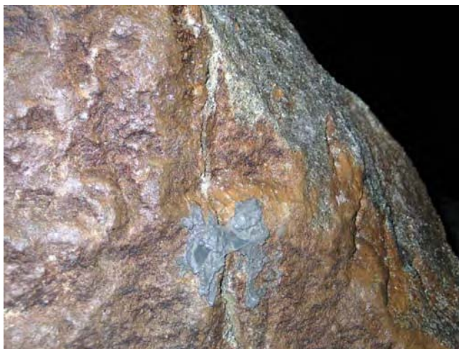
Obr. 2 Příklad trhliny v okolí pilíře
