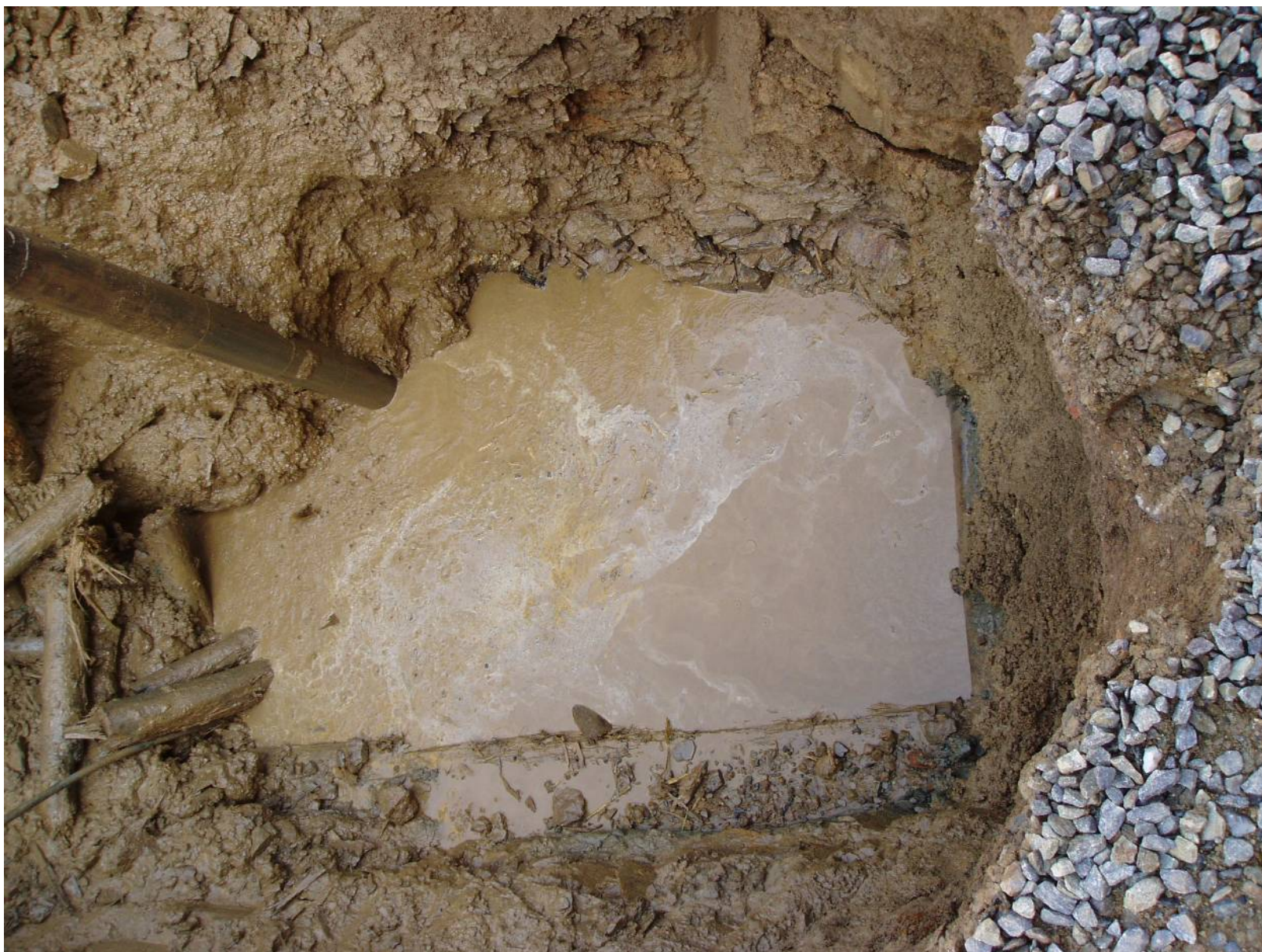
Obr. 5 Očištěný bok rámu v šachtě, 2009
