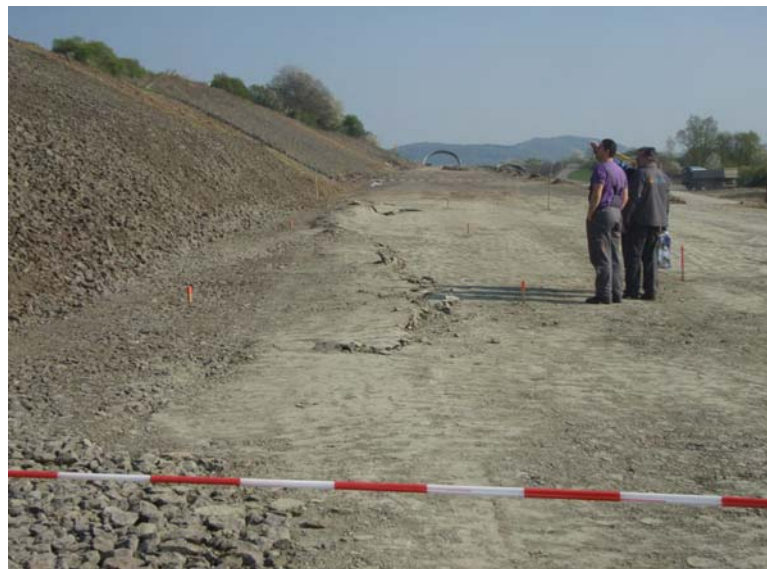
Obr.1 Výchoz hlubší smykové plochy po reaktivaci sesuvu č.2
