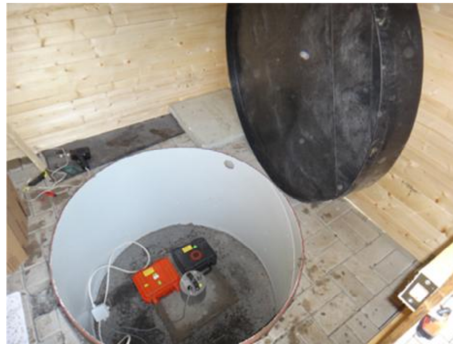
Obr. 4 Seismický pilíř stanice SKAC
