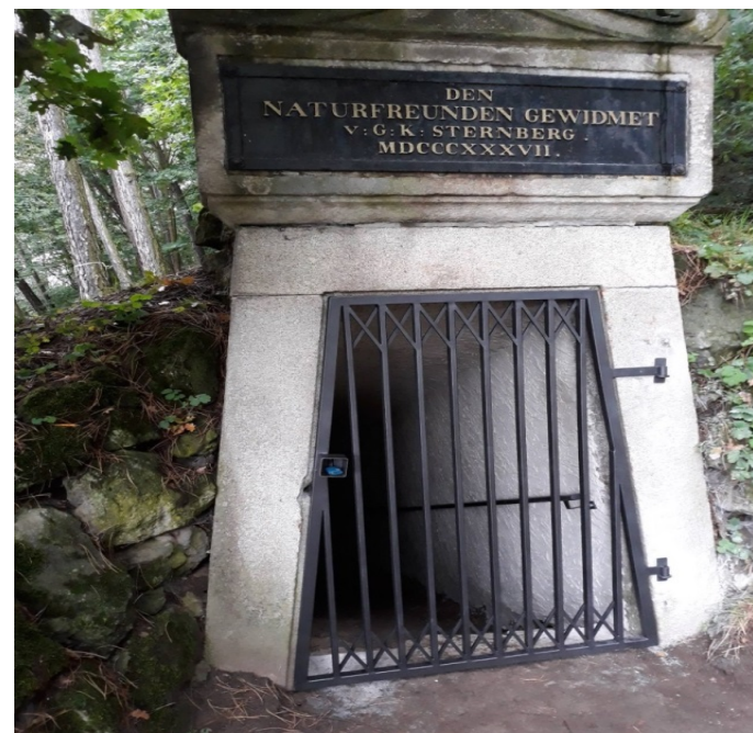
Obr. 4 Vstupní portál do Goetho štoly po opravě v roce 2017. Foto M. Brož
