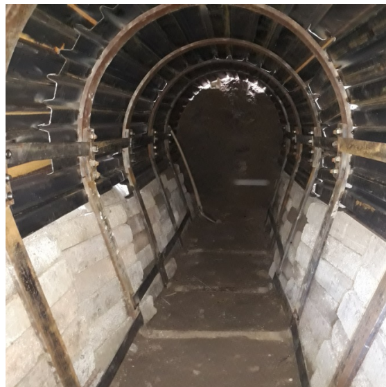
Obr. 11 První úsek podzemní chodby osazený pražskou výtuzí.
