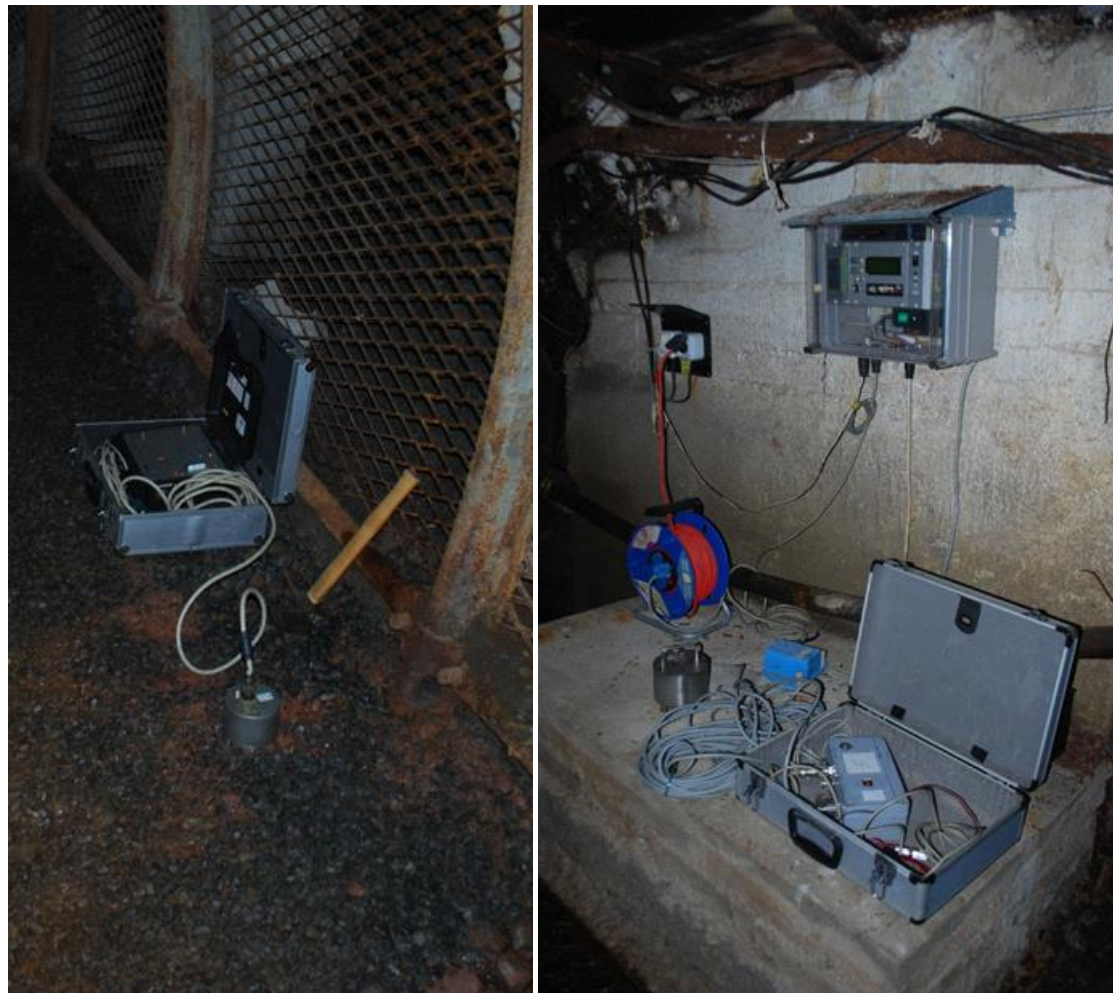
Obr. 2 Na obrázku vlevo je stanoviště BUK6 na 9. patře dolu s aparaturou Gaia a snímačem ViGeo2 umístěným na seizmickém pilíři trvalé stanice. Na obrzku vpravo je stanoviště BUK5 na 12. patře dolu s aparaturou Gaia a snímačem Lennartz Le3DLite umístěným na počvě chodby BZ-XIIJ (foto: Lednická)
