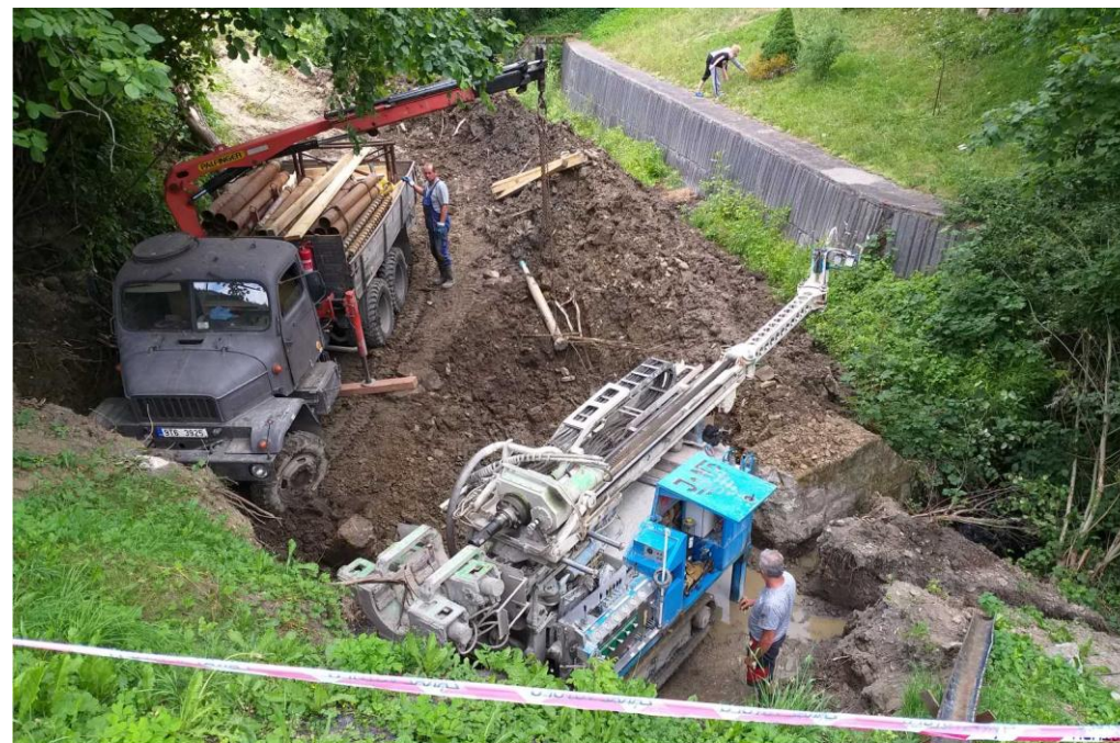
Obr. 3 Vrtání horizontálního odvodňovacího vrtu
