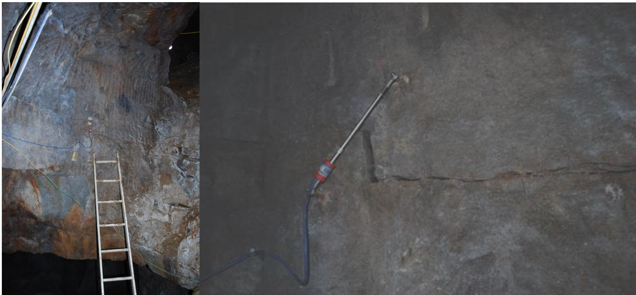
Obr. 2 Sledovaný blok v severní části komory K1(vlevo) a čidlo instalované přes puklinu v tomto bloku (vpravo). Foto: Rösnerová
