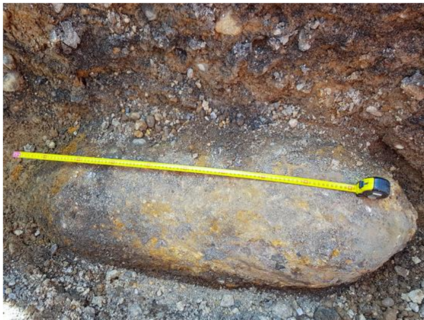
Obr. 1 Nevybuchlá letecká puma 500 lb ve výkopu
