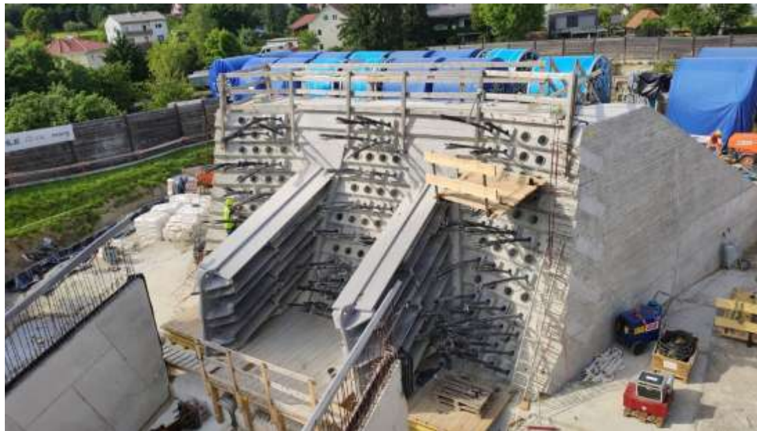
Obr. 2 Monitorovaný objekt: opěra mostu
