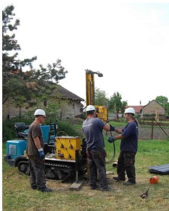
Hloubení monitorovací vrtu
